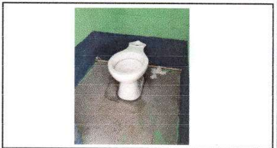
FOTO 6: SUSTITUCION DE INODORO.
